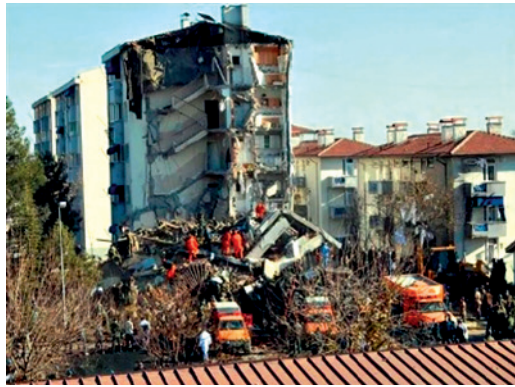
Schäden durch Kesselexplosionen (ORF Steiermark, 2012; FF Pinkafeld, 1996)
