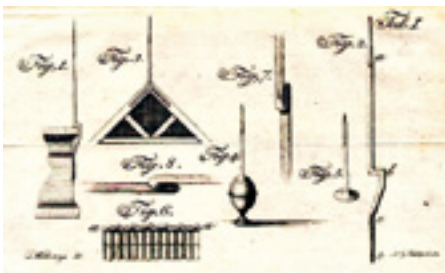
Abb. 6: G. C. Lichtenberg, Bauarten von Blitzableitern und Blitzschutzanlage an seinem Gartenhaus in Göttingen
